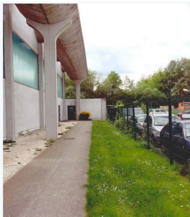
Longez le grillage des services techniques à l'arrière du gymnase Blaise Pascal. La petite porte au fond est celle du stand de tir.
